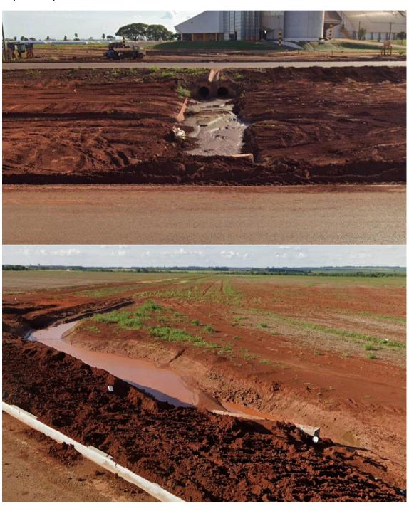
Inicialmente se faz necessário o caudal de projeto, sendo ele o mesmo despejado pelo projeto de dimensionamento de drenagem da MS 162, comprimento do Talvegue: 440 metros.
