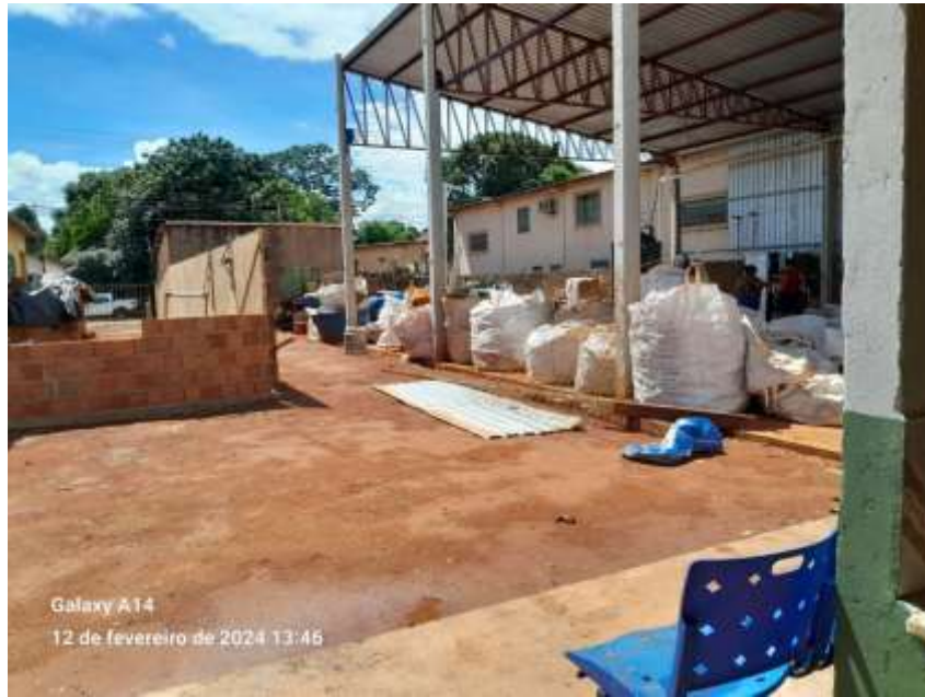
Figura 03 – UTR antes das obras de melhorias; Figura 04 – UTR após as melhorias, ; Figura 05 após as melhorias
